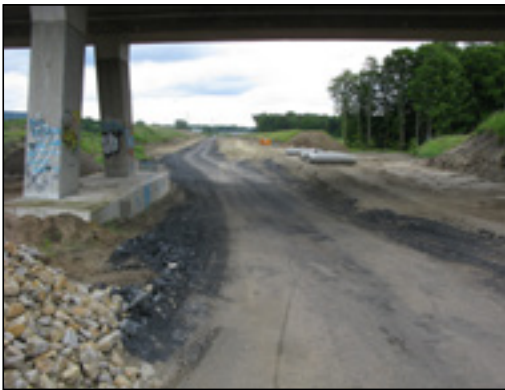
Abb. 5: Blick unter die Überführung der Bahnhofstraße an der A33-Brücke in Steinhagen in Richtung Osten auf die plattgewalzten Tonsteine aus Bad Oeynhausen vom Bau der dortigen A30-Ortsumgehung.
