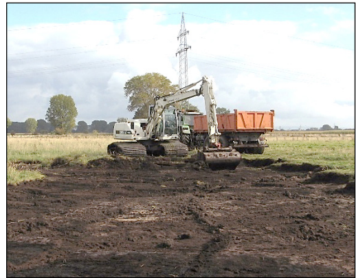
Abb. 24: Flacher Abtrag von Oberboden im Osten des Blockes IV (Foto: D. Esplör, Oktober 2008).
