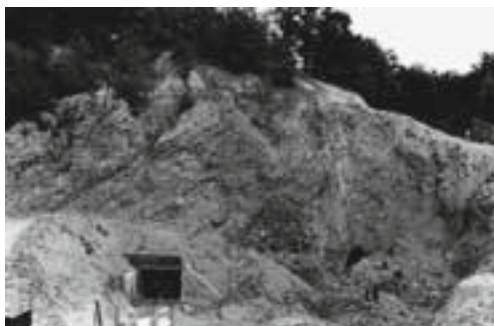
Abb. 11: Ehemaliger Gipsbruch in Stieghorst mit Stollenmundloch des Bergwerks Firma Breckweg. Aufnahme: 21. 6. 1969.
