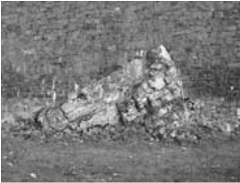
Abb. 8: Natürlicher Muschelkalkfelsen an der Basis der West-Kurtine zwischen Windmühlen- und Kiekstatt-Rondell.
