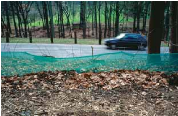
Abb. 2. Der Spanndraht war nicht alle 20 cm durchgefädelt, sondern hing oberhalb des Zaunes.
