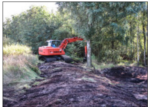
Abb. 3: Verdichtung des Materialaushubs von Oberflächenabschiebungen und der Torfkantenabschrägung (Foto: Dirk Esplör)
