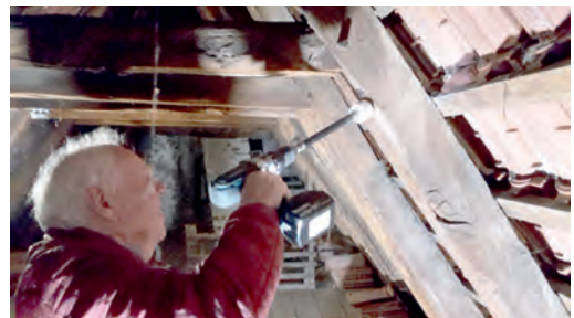
Kein Vandalismus, sondern Wissenschaft. Dendrochronologe Erhard Preßler nimmt Kernproben aus dem Dachstuhl des Spiegelshofes.
