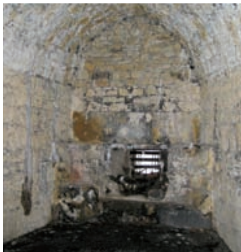
Teil der Kasematten im Windmühlenrondell
