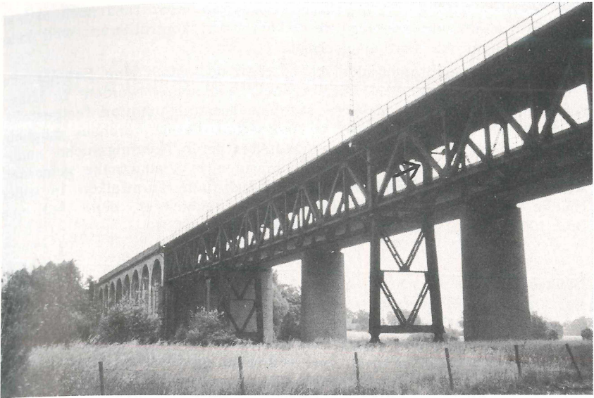
Abb. 5 Eisenbahnviadukt Bielefeld-Schildesche. Foto: Hilmar Hasenclever.
