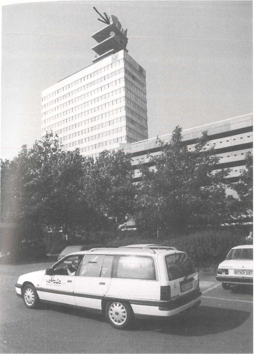
Abb. 1 Fernmeldehochhaus, Bielefeld, Kesselbrink. Foto: Rolf Siebrasse
