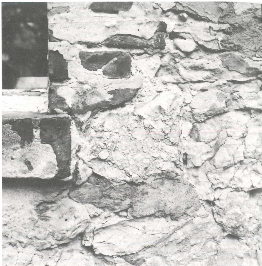
Abb. 2: Mauerwerk mit phacoidisierten Bruchsteinen an der Hauswand des Hofes Eikenbusch; R 34 77 210, H 57 53 200, TK 25: 4018 Lage
