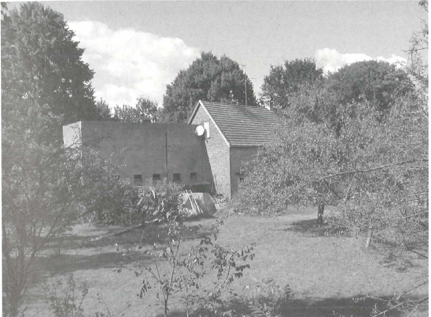
Abb. 15: „Kohlesilo“ der Zeche „Vereinigte Arminius“ in Halle Berghagen.
