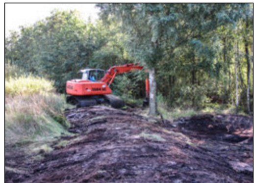
Abb. 3: Verdichtung des Materialaushubs von Oberflächenabschiebungen und der Torfkantenabschrägung (Foto: Dirk Esplör)
