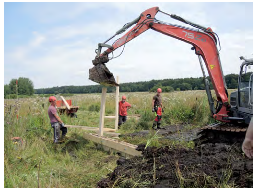
Abb. 15: In den zentralen Abschnitten wurden die Moordämme mit einem Holzkern gebaut (Foto: Peter Rüter).
