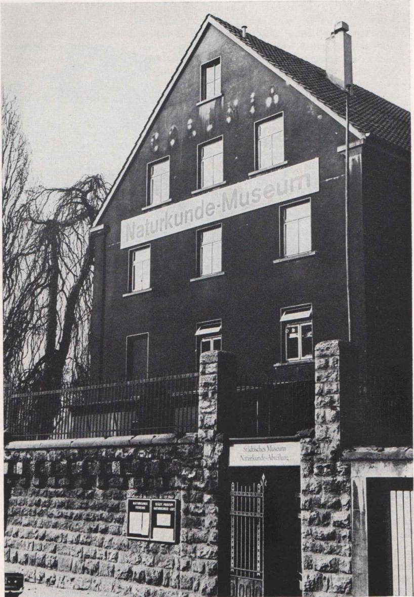
Abb. 3: Naturkunde-Museum der Stadt Bielefeld, Stapenhorststraße 1. Im Jahre 1964 geschaffenes Provisorium, das demnächst dem Bau des Ostwestfalen-Dammes weichen muß.
