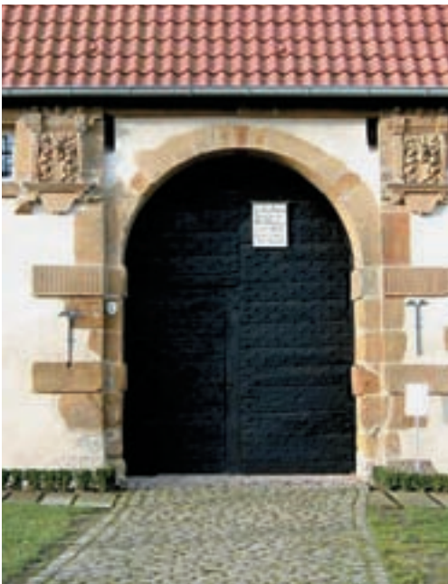
Ostportal des Werburger Torhauses, erbaut im Jahre 1596. Als Sichtmauerwerk wurde hauptsächlich der gelbbraune Osningsandstein (Unterkreide) verwendet.
