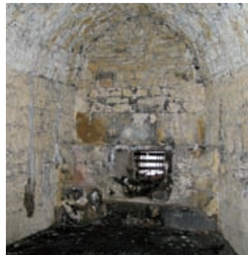
Teil der Kasematten im Windmühlenrondell
