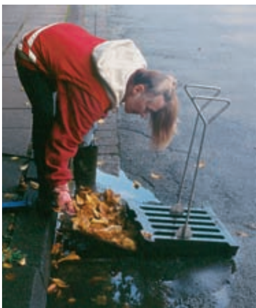
Brigitte Bender bei der Kontrolle eines Gullys
