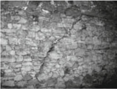
Abb. 6: Setzungsrisse in den unterirdischen Gängen in Nähe des Windmühlenrondells. Aufnahme 19.09.2011.
